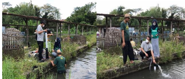
Gambar 6. Pemasangan instalasi airlift system di kolam ikan mitra PKM
