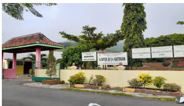
Gambar 1. Gedung Kantor Desa Katekan Gantiwarno, Klaten, Jawa Tengah.
