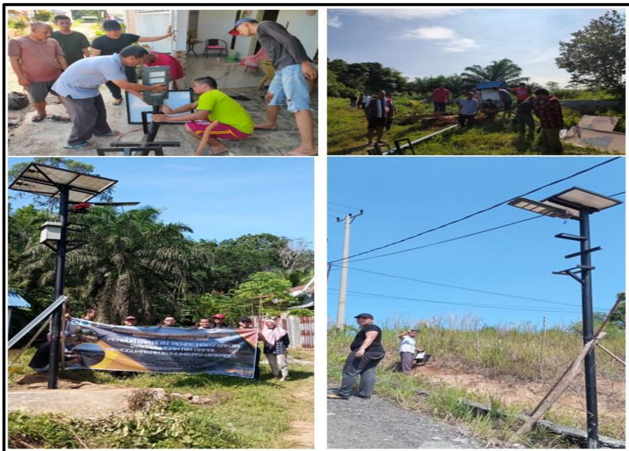
Gambar 7. Proses pemasangan alat
