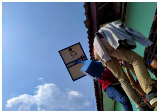
Gambar 5. Proses pemasangan lampu penerangan jalan swaenergi
