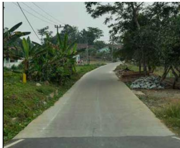
Gambar 4. Infrastruktur Jalan Desa Sindangheula
