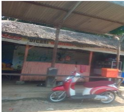
Gambar 1.1 Fasilitas Umum yang Tidak Terawat
