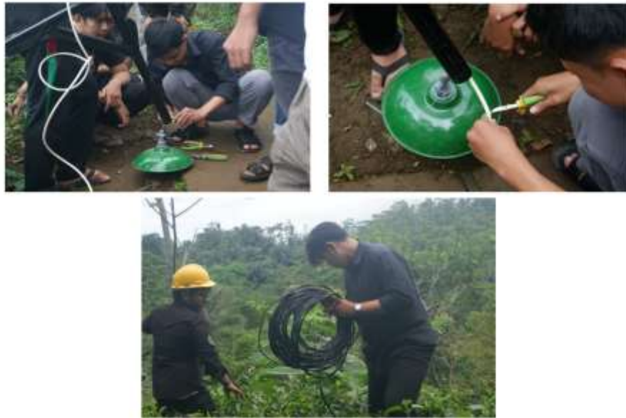
Gambar 3. Proses pemasangan Penerangan Jalan Umum (PJU)
