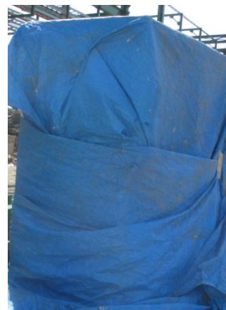
Gambar 9. Pelindung pada material yang dilas
